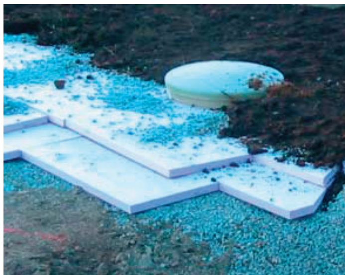
Frostsikring av tanker
