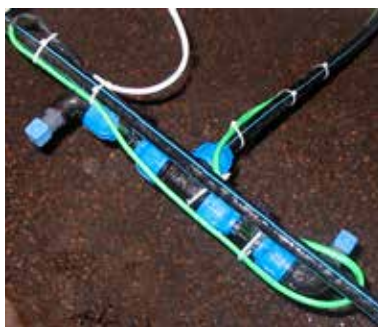
Varmekabel i biofilteret
