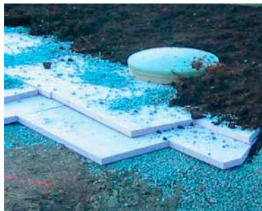
Frostsikring av tanker
