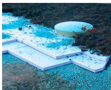
Frostsikring av tanker
